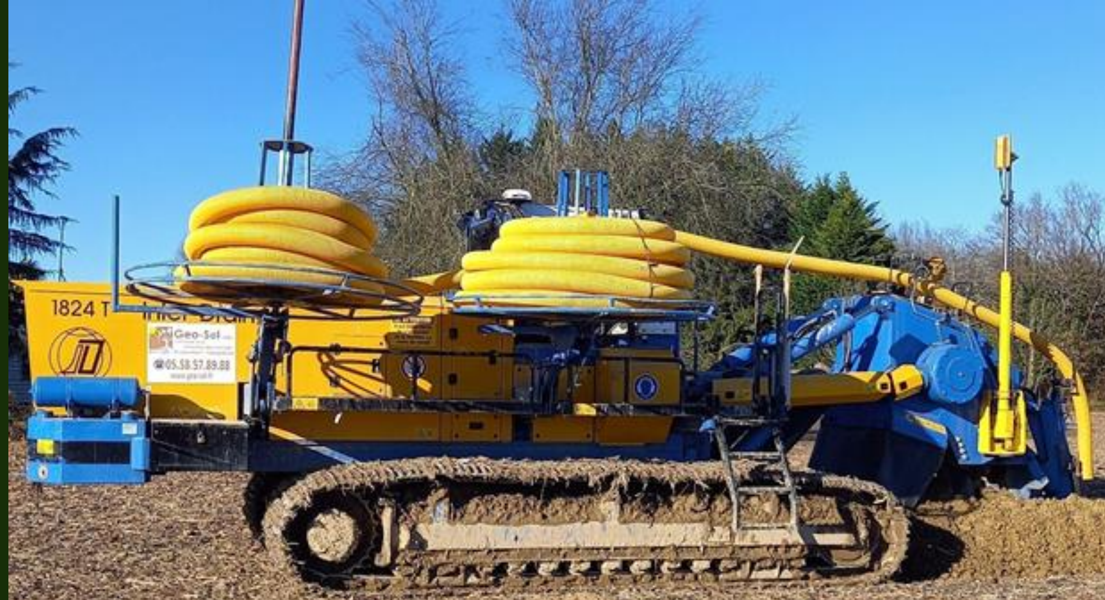
Draineuse- trancheuse dernière génération équipée d'un RTK de la société Geo-Sol à Mugron
